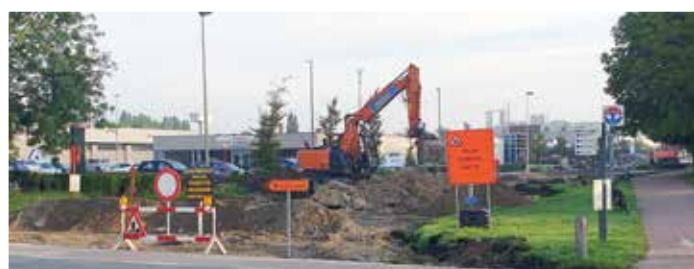
▲ De Ringlaan krijgt een breder wegdek in asfalt en veiligere oversteekplaatsen.
